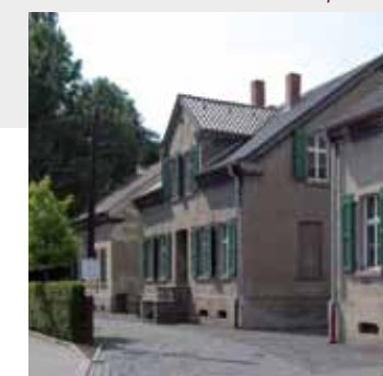
Koloniehäuser Am Rübenkamp
